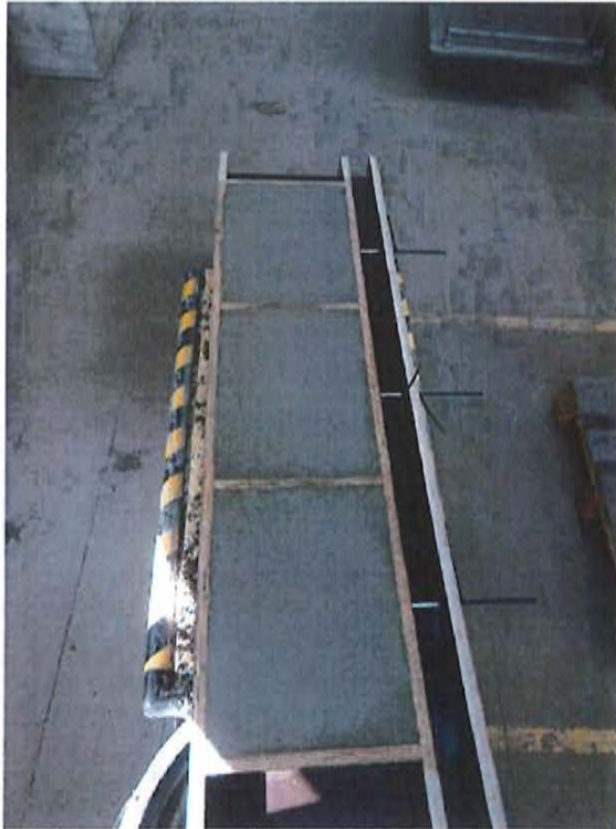
Bild 3: Prüfkörperherstellung – Einbringen des Estrichs
