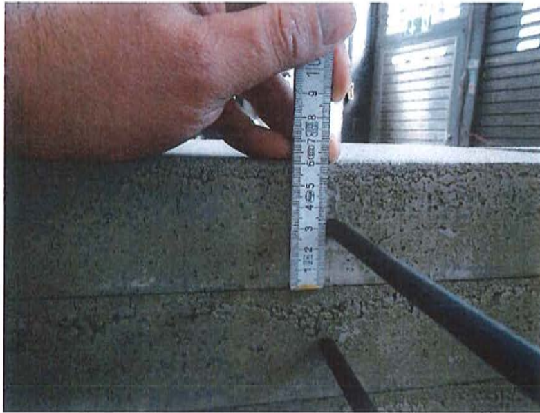
Bild 5: Mittige Lage der Dübel
